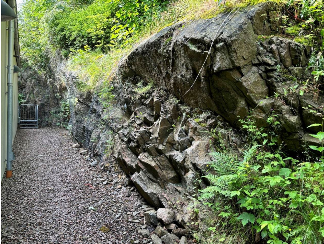
Figur 16 Foto som visar sprängd bergvägg vid Chalmers teknikpark. Foto Petro Marin.
